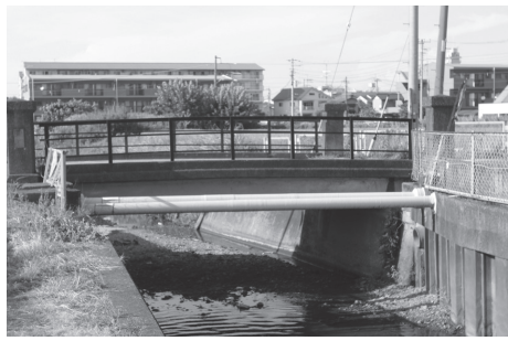
新河岸川起点近くの八幡橋
